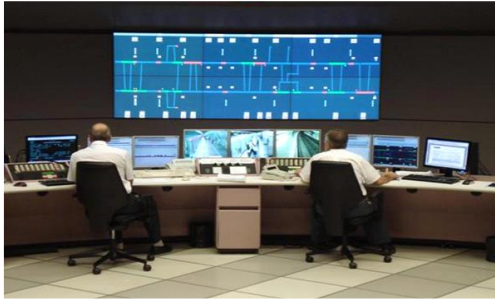
CENTRO DE CONTROL OPERACIONAL - CCO
